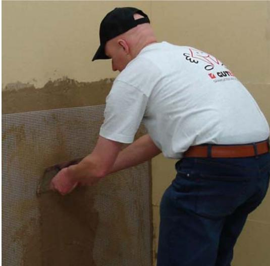
GUTEX Thermoroom: Lehmputzauftrag direkt auf der Dämmplatte
