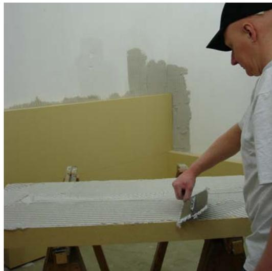
GUTEX Thermoroom: Anbringung stoßversetzt an der Innenseite der Außenwand
